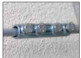
**KK, Kreuzklemme;** zum Verbinden von Runddrahnen und Erdungsbandeisen, in Kreuz- und T-Anordnung fur ober- und unterirdische Verbindungen
