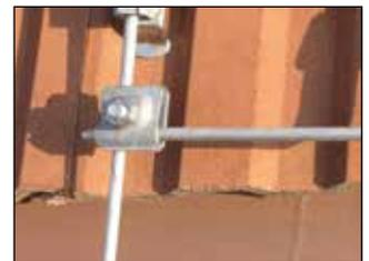
**LH, Leitungshalter;** zum Befestigen von Leitungen, mit Zweischrauben-Überleger, für Rund- und Flachleiter
